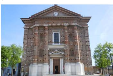
Chiesa S. Bartolomeo Apostolo (Castenedolo - BS)
