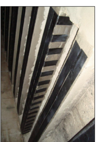
INTERVENTO IN FIBRE DI CARBONIO
