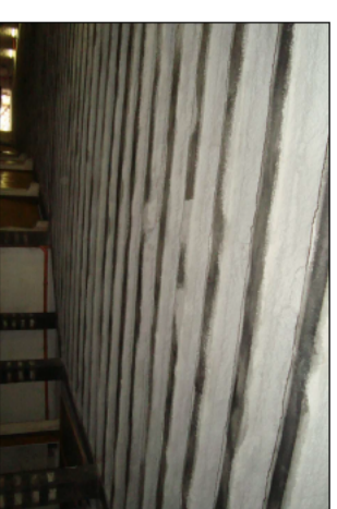
INTERVENTO IN FIBRE DI CARBONIO
