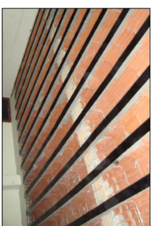
INTERVENTO IN FIBRE DI CARBONIO E COLLAUDO
